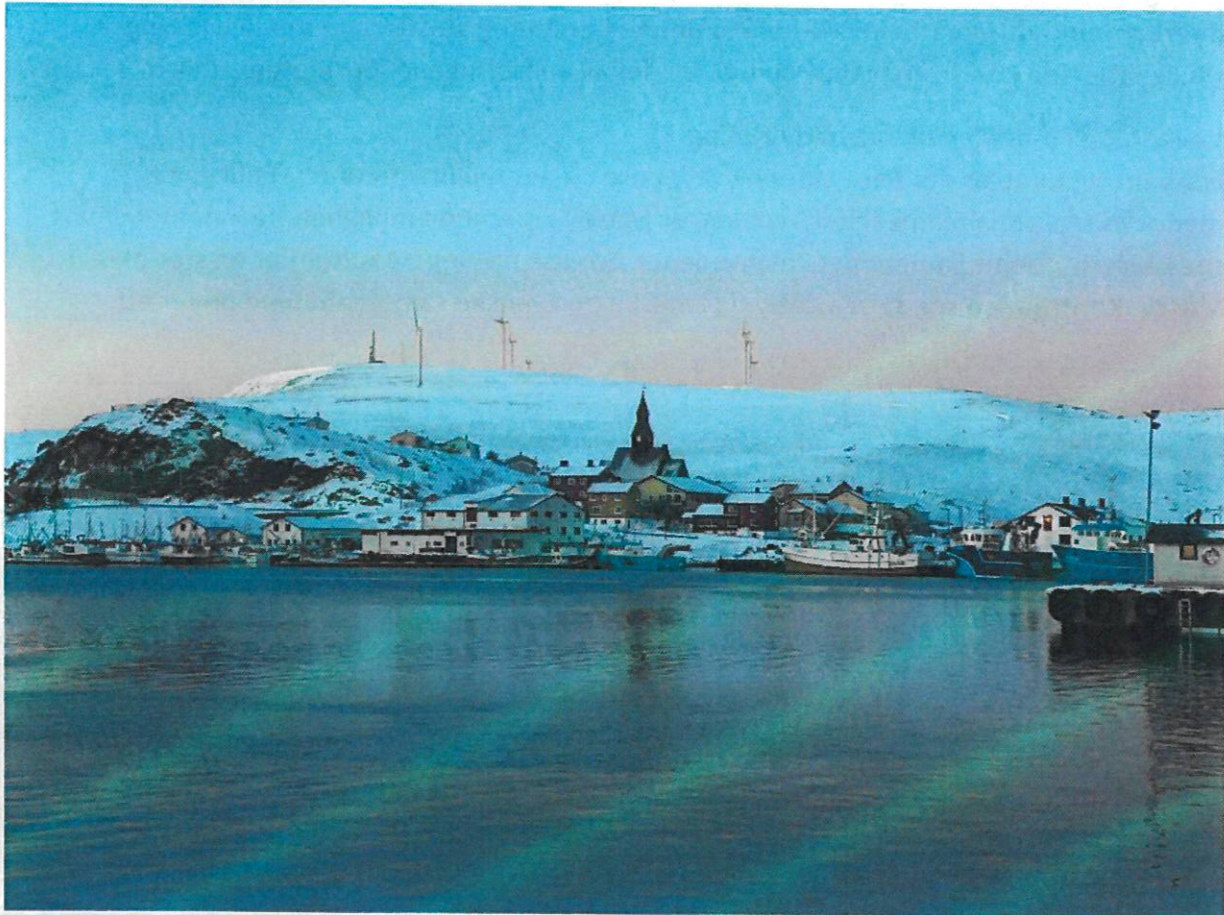
Utsnitt av Havøysund med Havøygavlen vindpark i bakgrunnen.
