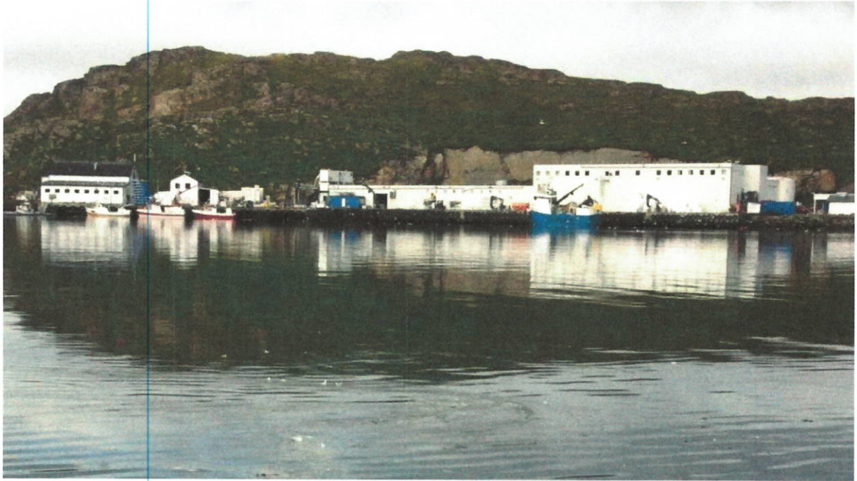
Bilde 1: Bebyggelsen i området sett fra sør - sørøst
